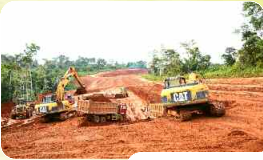
Déblais du PK4+300-PK4+800
