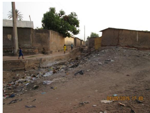
Photo 30 : Amas de déchets obstruant les zones ravines à Demsaré
