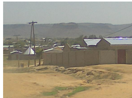
Photo 40 : Même phénomène à Doualaré
