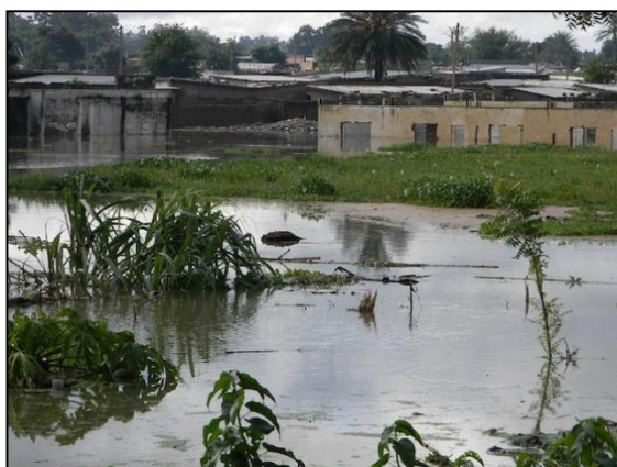
Photos 35 : Dégâts provoqués par les inondations de 2012...
