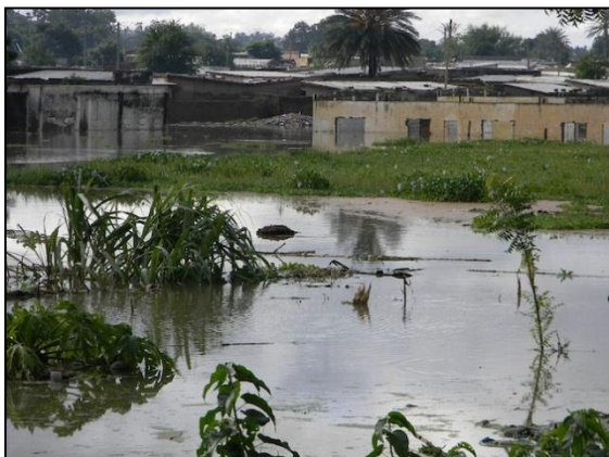
Photos 3 : Dégâts provoqués par les inondations de 2012...
