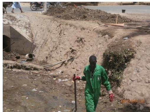
Photo 22 : Curage d'un canal des eaux pluviales
