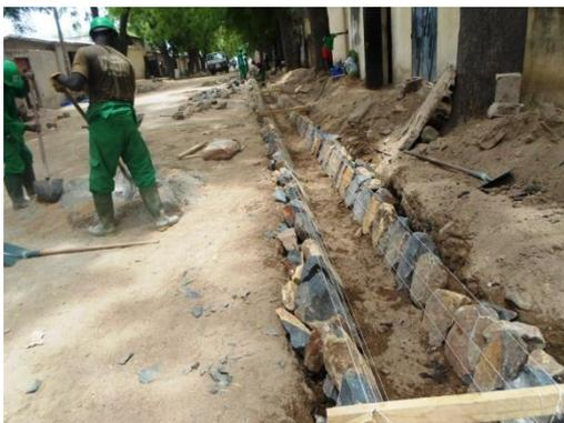
Photo 21 : Travaux pour la réalisation de caniveaux à Maroua
