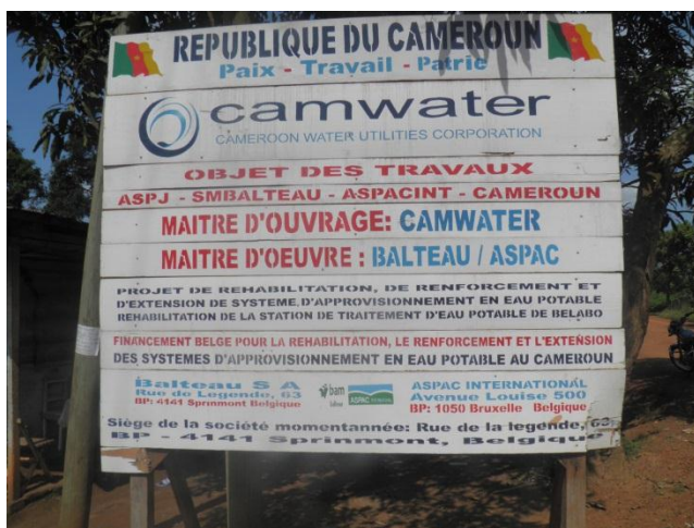
Image N° 88 : plaque de chantier Camwater
