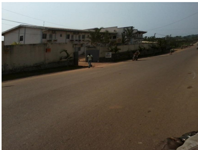
Image N° 22 : Voirie secondaire bitumée
