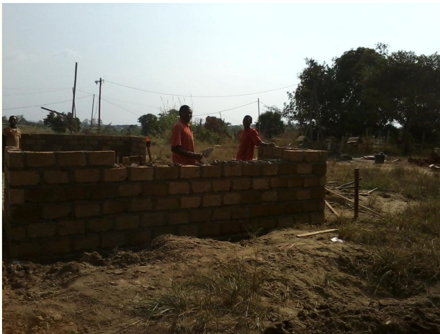
Image N° 6 : Construction en agglomérés de terre
