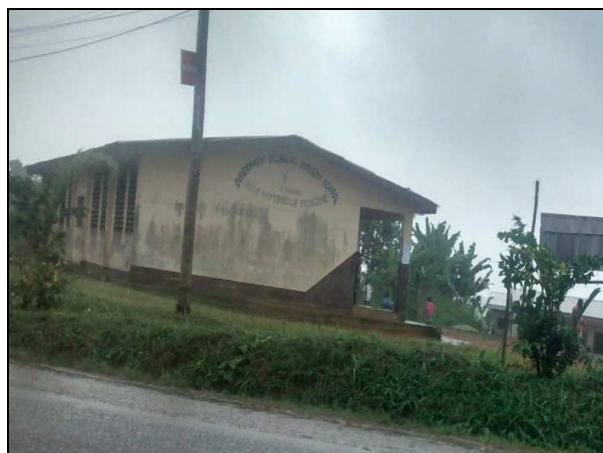
Image N° 23 : école maternelle bilingue d'Angalé Jungle. Cette école n'a pas de clôture, ce qui expose les enfants qui inconsciemment peuvent se retrouver à jouer sur la voie publique. Aussi l'accès est facile pour chaque passant
