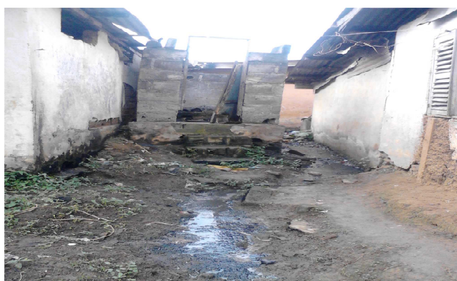
Image N° 45 : Latrine mal conçue au quartier Amang IV
