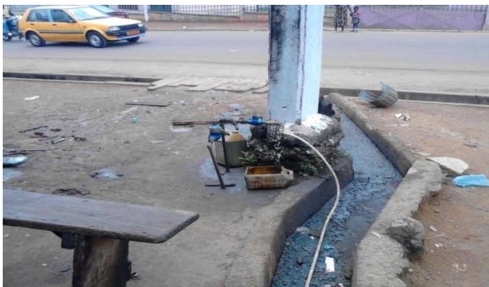
Image N° 47 : Huile de vidange déversée sur le sol dans un garage et dans le réseau d'assainissement des eaux usées au quartier Amang II et pourrait contribuer à la destruction de la faune des cours d'eaux.
