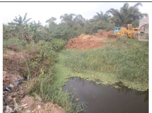
Image N° 8 : absence du curage des drains à Nko'ovos II.
