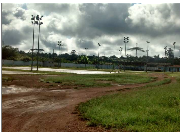
Image 6.20 : Complexes sportifs de Nko'ovos. Cette infrastructure est moderne et nécessite un entretien et une maintenance accentués.
