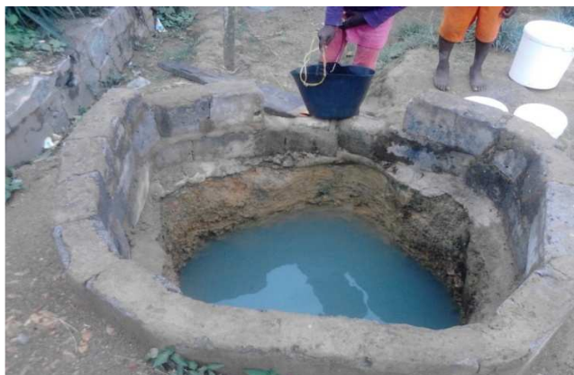
Image N° 51 : Puits près des latrines au quartier John Holt
