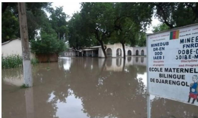
Ecole à Djarengol envahie par les eaux lors des dernières inondations d'Août 2015
