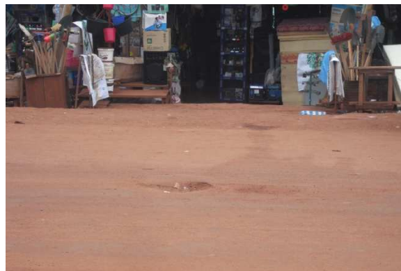
Photo 16: Voie menant au centre administratif, bitumée mais souffre du manque d'entretien. Dégradations de la chaussée avec des Nids de poule et épaufures.
