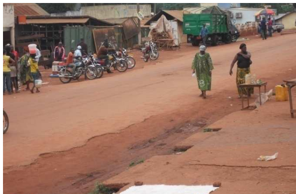
Photo 16: Voie menant au centre administratif, bitumée mais souffre du manque d'entretien. Dégradations de la chaussée avec des Nids de poule et épaufures.
