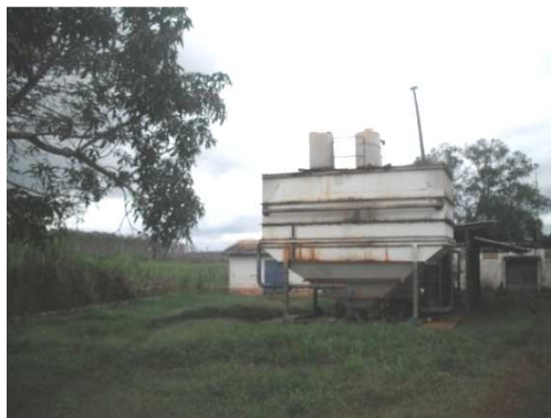
Photo 26: Vue de la station de traitement Des eaux à Abong-Mbang.
