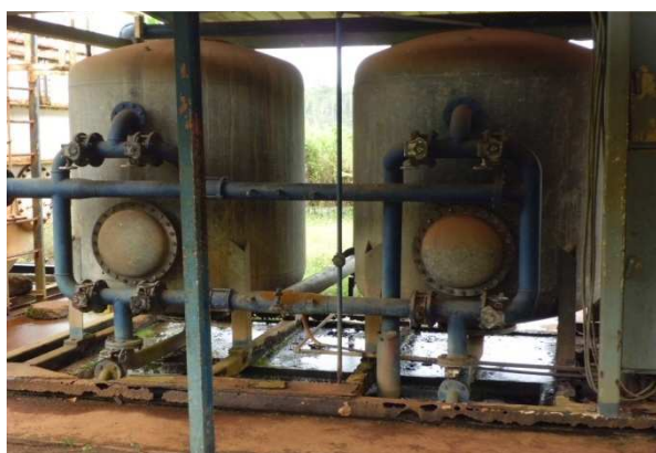
Photo 27: Etat d'abandon et de vieillissement des matériels de la station de traitement
