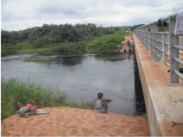
Photo 10: Garde-corps aménagé sur le pont du Nyong
