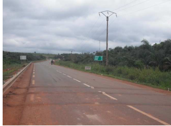
Photo 11: Glissières de sécurité présentes sur la nationale Yaoundé-Bertoua
