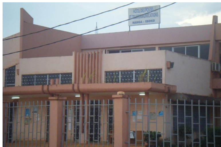
Image N° 28 : Hôtel des Postes et Télécommunications
