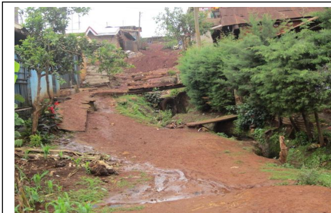
Une voie d'accès au quartier TCHITCHAP Observer le système d'assainissement
