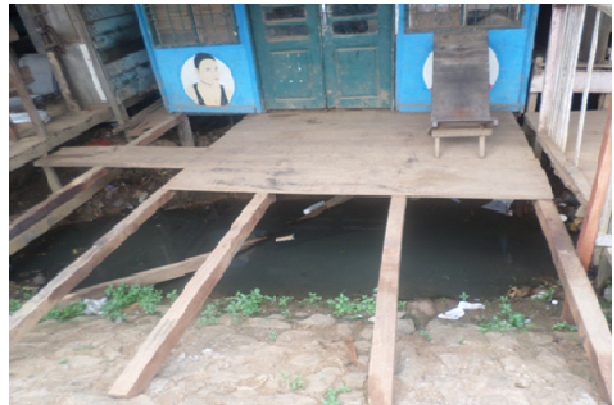
Figure 46 : Construction sur pilotis dans des zones marécageuses aggravant le risque d'inondation
