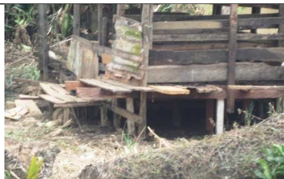
Figure 4 : Porcherie de fortune au quartier Malla d'une capacité de 4 porcs (cliché HTR, 2015)
