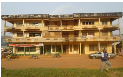
Figure 22 : Une vue du vieux immeuble qui loge les DD/MINEE, DD/MINCOMERCE, DD/MINMESSA (Cliché HTR, 2015)
