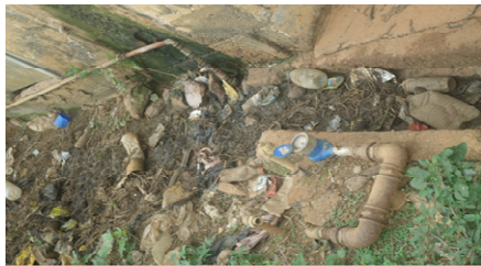
Figure 34 : compteur et réseau de distribution tertiaire en fonte (Cliché HTR, 2015)
