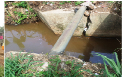
Figure 34 : Réseau de transport PVC à Tétém (Cliché HTR, 2015)
