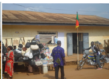
Figure 22 : Bâtiment abritant les DD/MINSEP et DD/MINJEC en plein marché (Cliché HTR, 2015)
