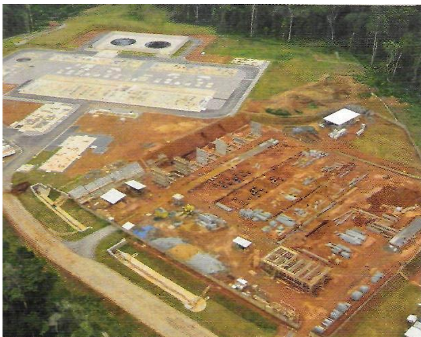
Photo 20 : Construction de la Centrale à gaz de Kribi (Polongwé)
