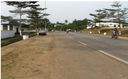
Photo 14 : Carrefour PTT – Rond point Texaco ; accotement à entretenir
