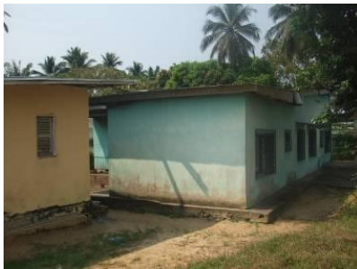
Photo 7 : L'habitat moderne fait en matériaux définitifs
