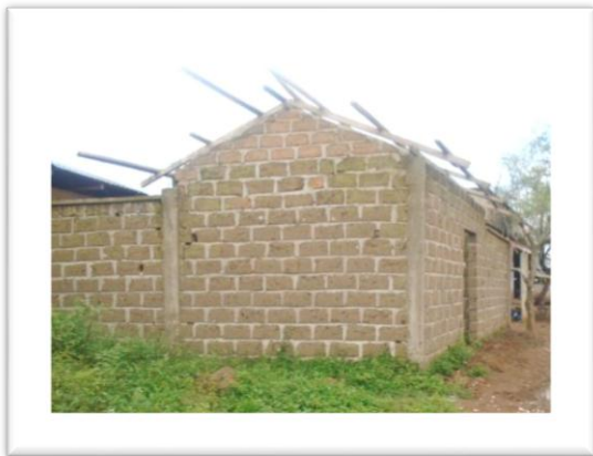
Construction d'une maison en semi dur X=13,26955E ; Y=6,46785N ; Z=975m
