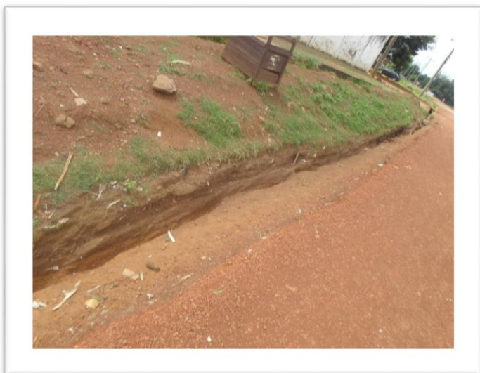
Canal d'irrigation le long de la route au sein de la ville de Ngaoundal
