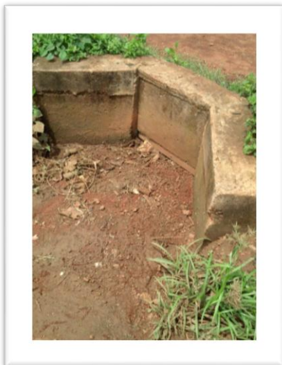
10. Entrée petit ouvrage hydraulique 11. Sortie petit ouvrage hydraulique
