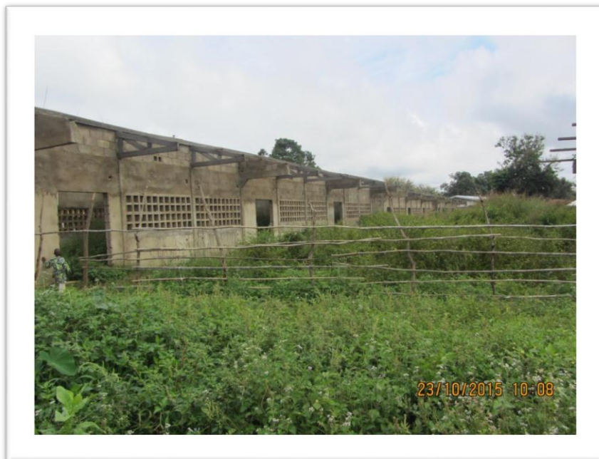
Salle d'école publique de Ngaoundal en construction X=13,27126° Y=6,46515° Z=969
