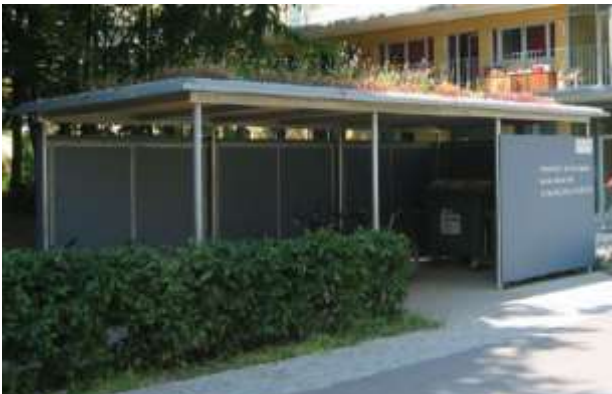
Photo 28- Abris poubelles et vélos protégés par une toiture végétalisée - sedum - participant ainsi à la réduction des eaux de ruissellement.
