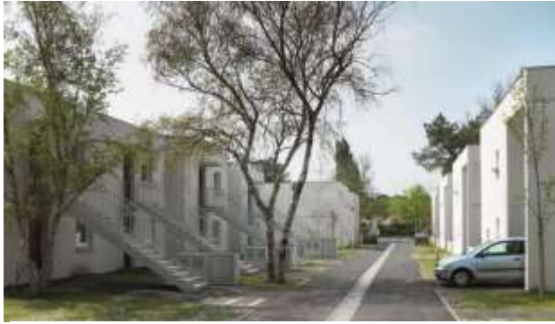
Photo 34- Entre voie de desserte et logements, une bande végétalisée assure la transition. Les plantations existantes ont été renforcées et le stationnement privatif y a pris place.
