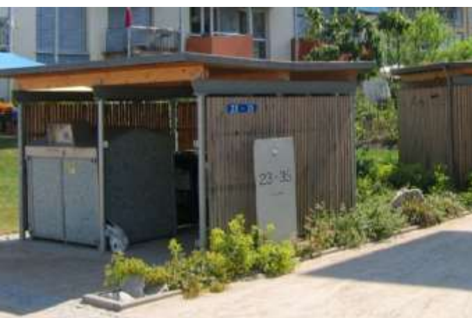
Photo 29- Abris pour conteneurs collectifs et abris vélos en bois, disposés en limite des espaces collectifs.
