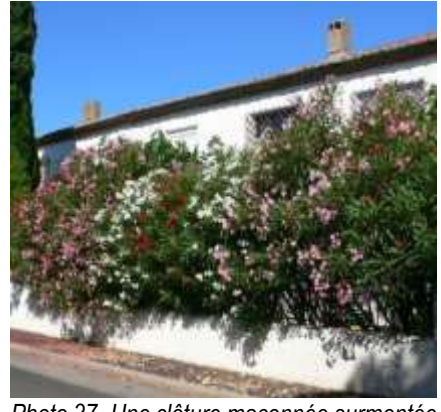
Photo 37- Une clôture maçonnée surmontée d'une ferronnerie et doublée d'une haie végétale : la qualité de cet exemple tient à la réalisation d'une haie libre et débordante
