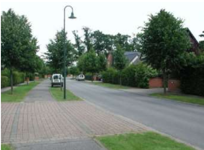
Photo 18- Cette voie structurante intègre du stationnement latéral sur ses bas-côtés
