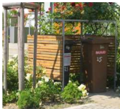
Photo 30- Abri pour poubelles individuelles, dont la structure est le support de plantes grimpantes.
