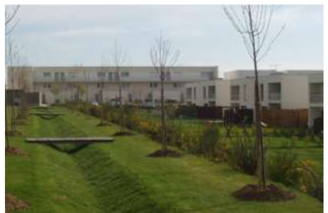
Photo 13- En cœur d'îlot, des jardins structurés par des grandes noues enherbées canalisent les eaux pluviales.
