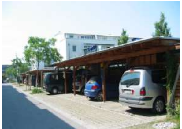
Photo 31- Stationnement collectif : des abris collectifs, disposés parallèlement à la voie de desserte, procurent de l'ombre et offrent des possibilités de rangement au-dessus de chaque place de stationnement.
