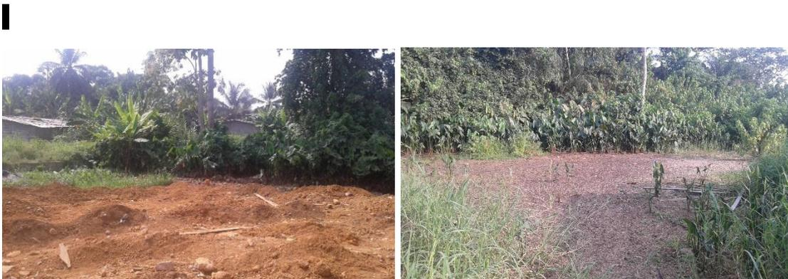
**Figure 12 : remblayage des marécages. A gauche, remblayage avec de la terre et à droite, avec du copeau ou de la sciure.**
