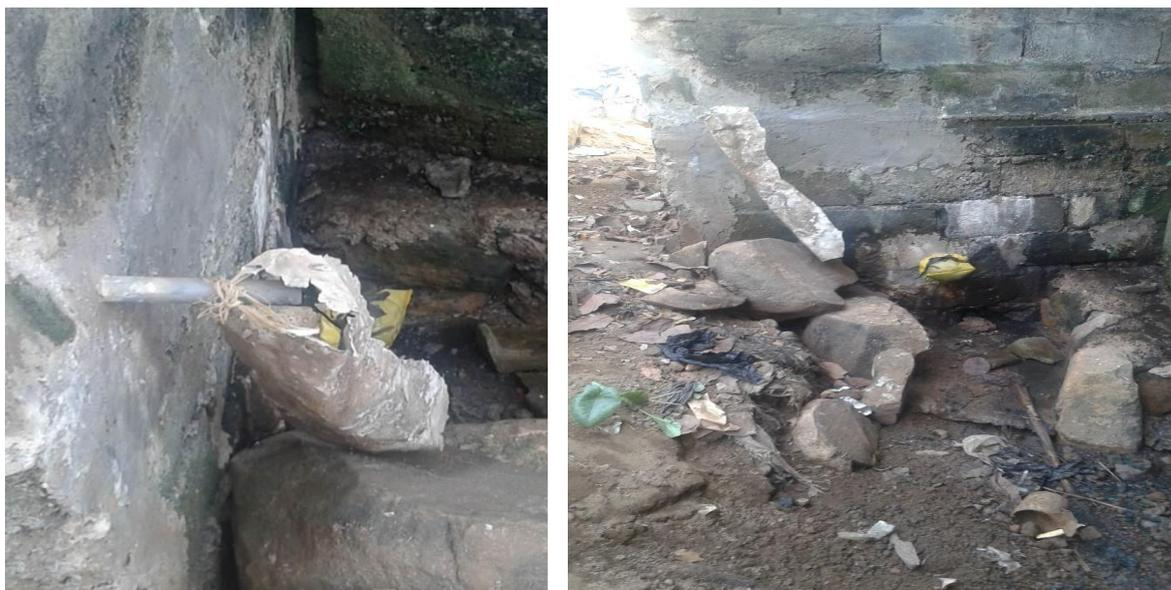
**Figure 22 : canalisation des déchets liquides et des excréta (WC à canon)**
