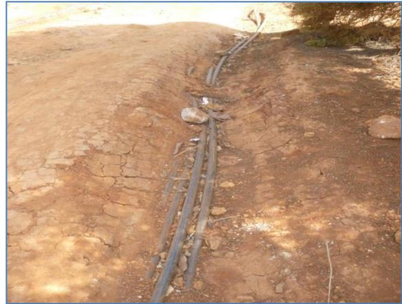
**Photo 26:** Canalisations bouchées sur voirie primaire à Famkeu et ravinement dû à l'écoulement des eaux de pluie exposant les canalisations de la CDE à Nguenack
