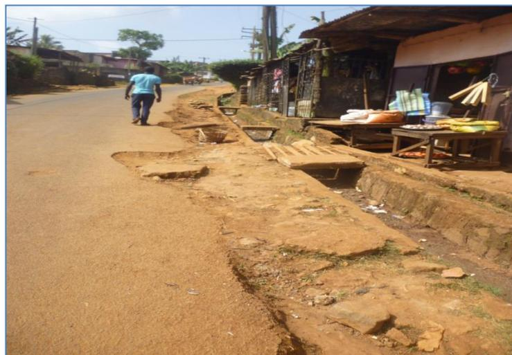
**Photo 28:** Ravinement dû au débordement des eaux de pluie à cause des caniveaux très réduits et de l'importance des pentes à Leuchi-Mouankeu.
