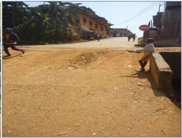
**Photo 27:** Activité anthropique sur un réseau d'écoulement des eaux à Bavi et ravinement dû au débordement des eaux de pluie à l'entrée d'un ouvrage de franchissement dans une voirie tertiaire à Tetue.
