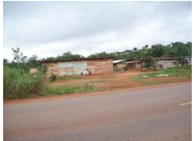
Photo 6: Baraques en bois en bordure route
