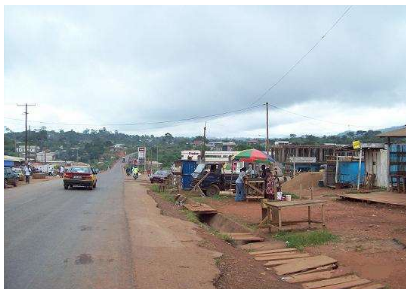
Photo 12 : Vue sur la voie 8066 au quartier Mvan
