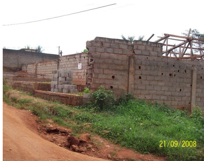
Photo 19: Voie en terre mal entretenue
