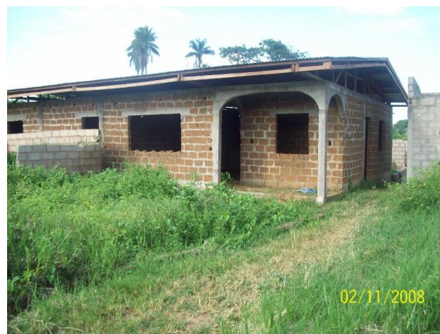
Photo 15: Maison en briques de terre non stabilisées
