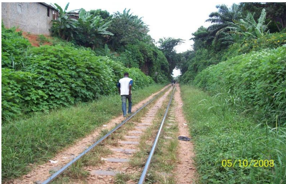
Photo 7: Utilisation des rails comme chemin piétonnier
