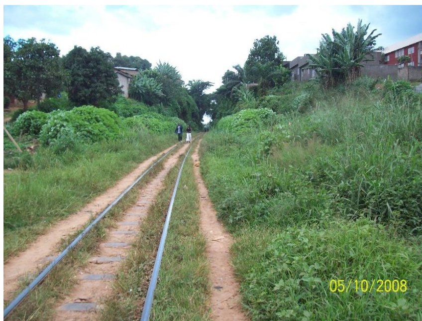
Photo 8: Occupation illégale des emprises du chemin de fer
