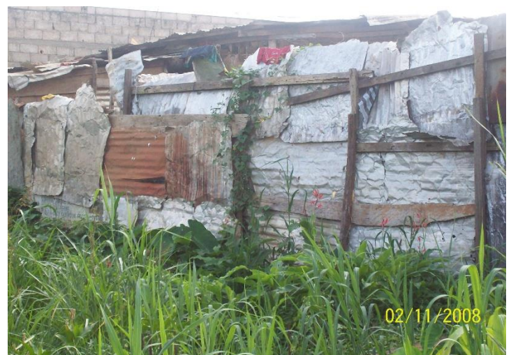
Photo 13: Barrière en tôles de récupération au quartier Eman
