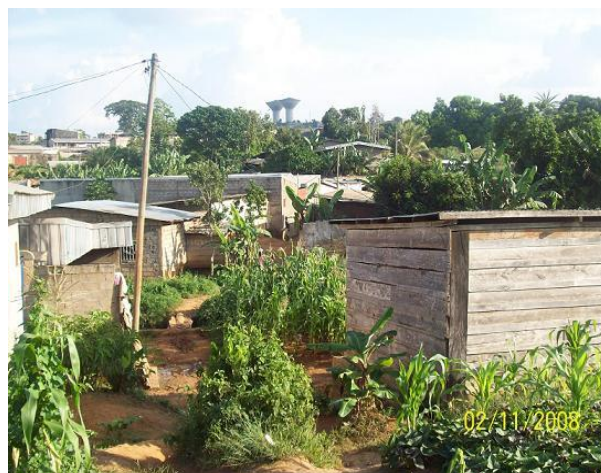
Photo 11: Espace des constructions anarchiquement occupé au quartier Emanas
