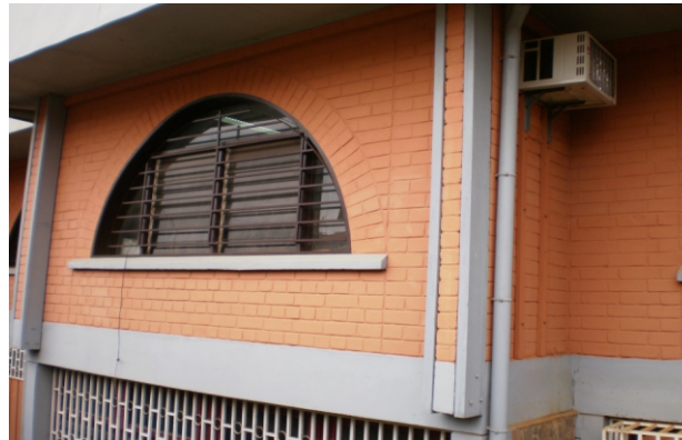
Photo 11: Construction d'un gymnase de sport de combat à l'INJS de Yaoundé vers les années 1994.
