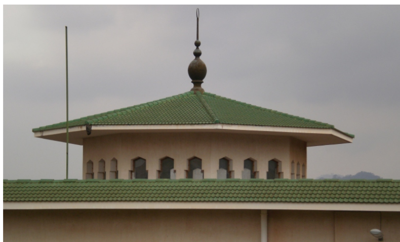
Photo 16: Couverture en tuile béton double roman verte âgée de plus de 10ans.
