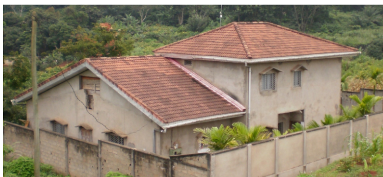
Photo 15: Couverture en tuile double roman âgée de plus de 5ans.
