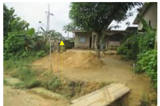
Photo 4: Niveau des eaux lors des inondations
