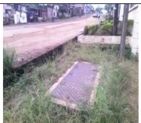
Photo 19: Regard CAMTEL sur la bretelle Fin goudron Logpom- Hôpital des sœurs
