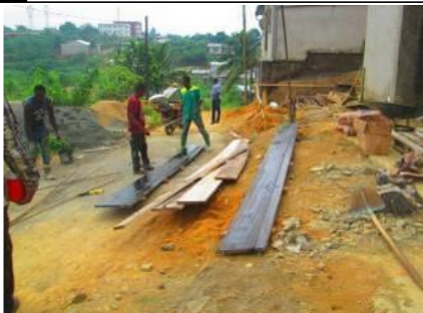
Photo 26: Restriction de l'emprise par les constructions et les installations commerciales
