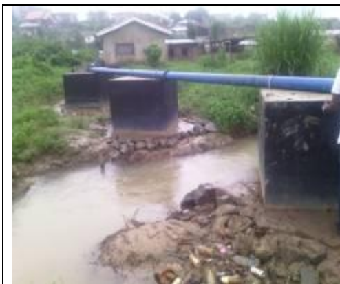
Photo 20: Tuyau en fonte à déplacer pendant la construction du drain
