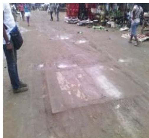
Photo 23: Regard sur le réseau de gaz au marché carrière
