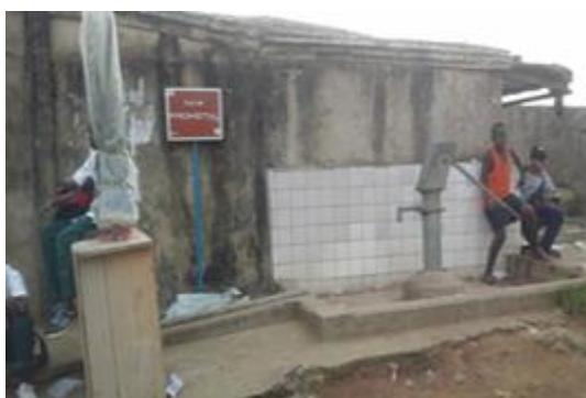
Photo 13: Point de ravitaillement en eau potable
