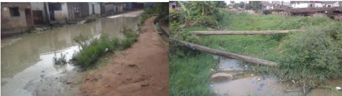
Photo 8: Présence des mares d'eau sur la chaussée
