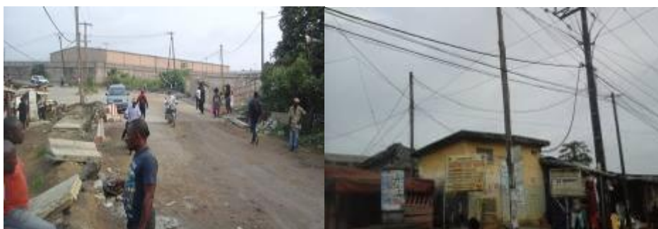
Photo 12: Présence des réseaux aériens et d'un pylône de haute tension le long du tracé
