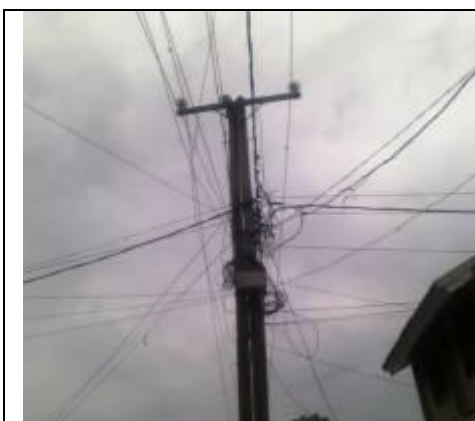
Photo 16: Support en bois portant plusieurs types de réseaux aériens
