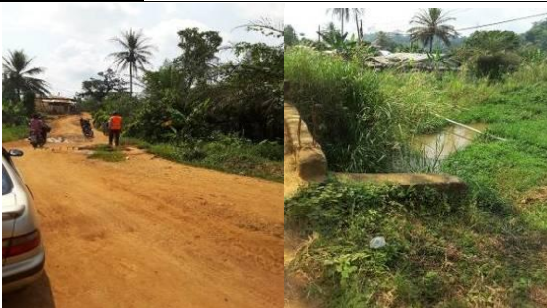
Photo 5: Etat des lieux du tronçon Widerness Junction - intersection Nationale N°8
