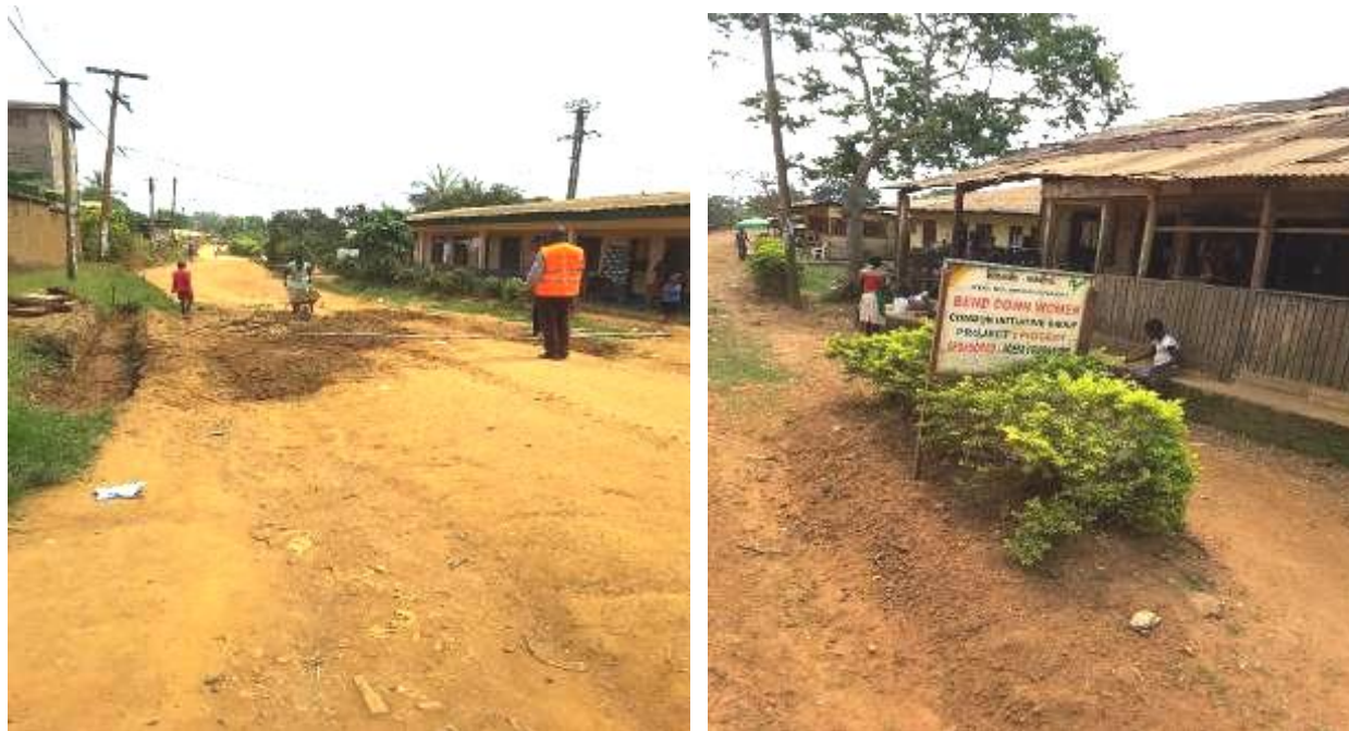
Photo 6: Etat des lieux du tronçon Seminary Pulletin Street-intersection Nationale N°8
