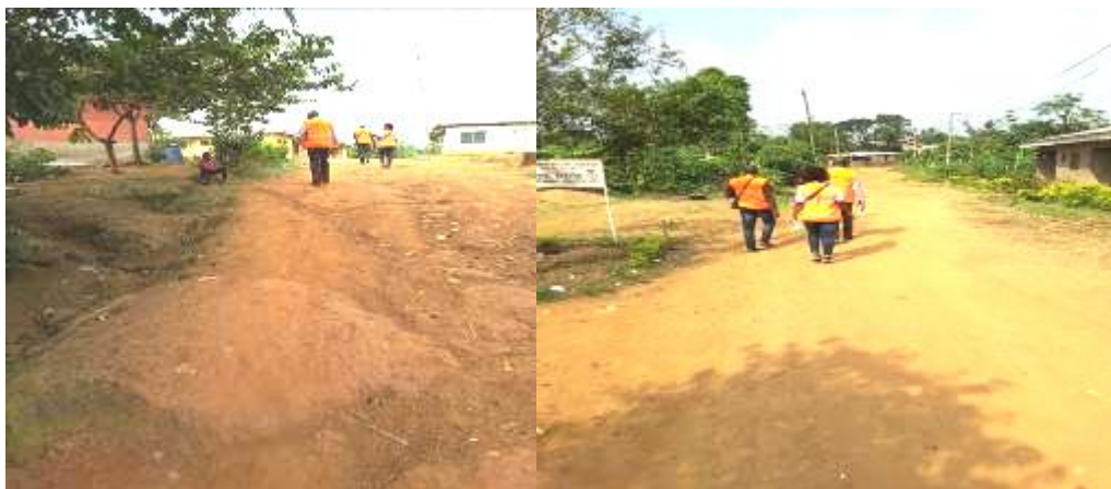
Photo 1: Présence de ravines sur la chaussée Photo 2: Présence de réseaux aériens sur le tronçon
