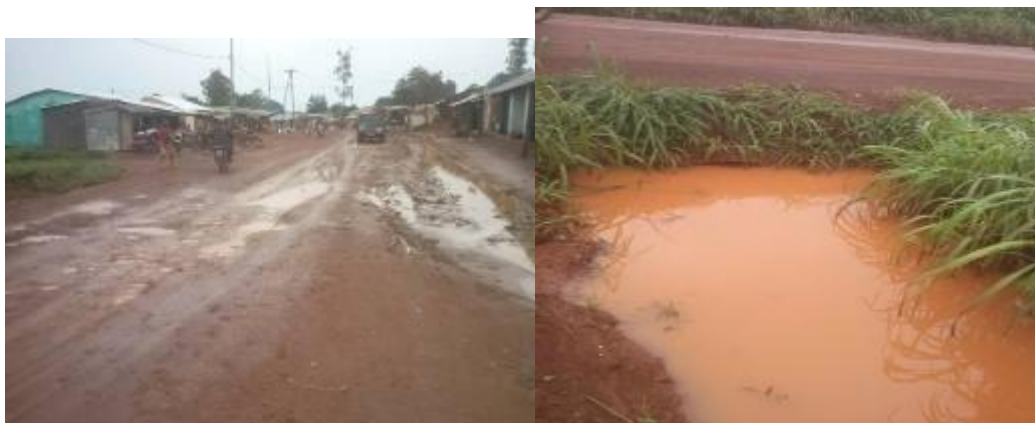
Photo 8: Etat des lieux du tronçon NG4
