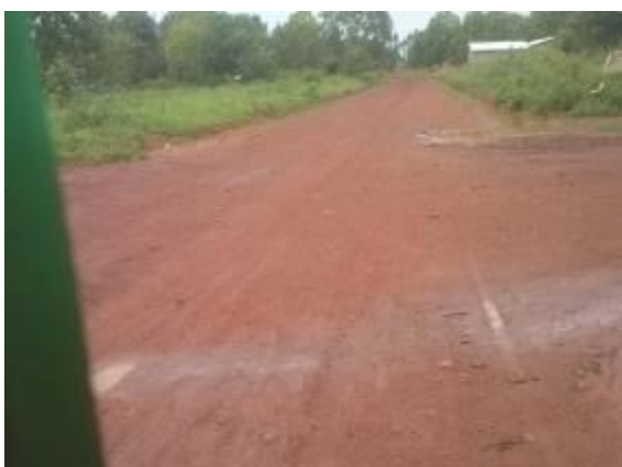
Photo 12: Tracé en terre en bon état chaussée
