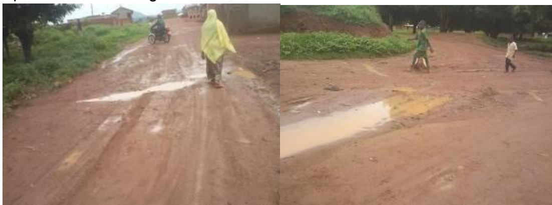
Photo 9: Etat des lieux du tronçon NG5
