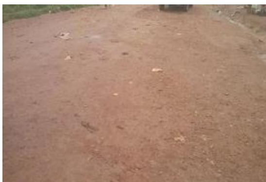
Photo 10: Tracé en terre en bon état
