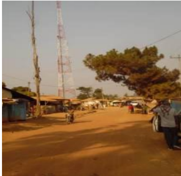
Photo 22: Pylône de télécommunications à Gada-Mabanga
