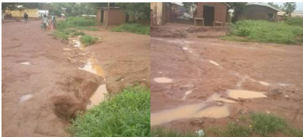
Photo 7: Etat des lieux du tronçon NG3
