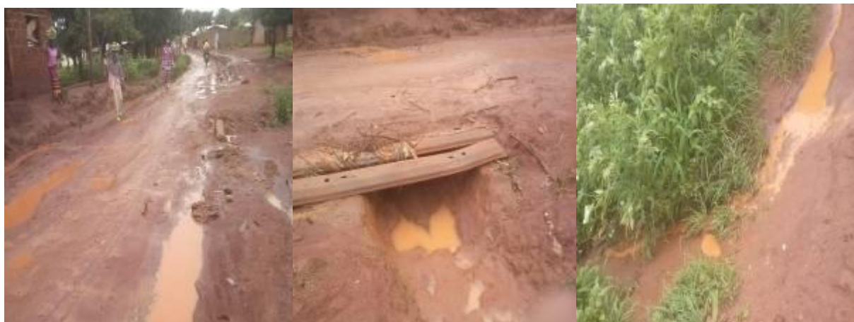
Photo 6: Etat des lieux du tronçon NG2
