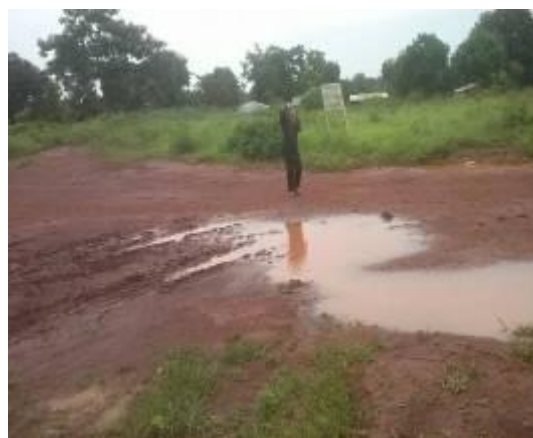
Photo 13: Présence d'eaux stagnantes et de bourbiers sur la
