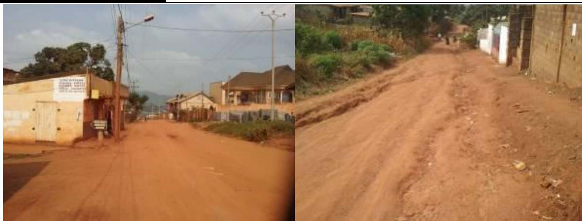
Photo 4 : Présence des maisons d'habitation et du réseau électrique sur l'emprise du Projet dans la CAY 7
