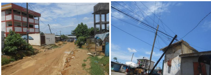
Figure 5: Descente de la route secondaire et toile d'araignée et fil électrique haute tension sur le toit
