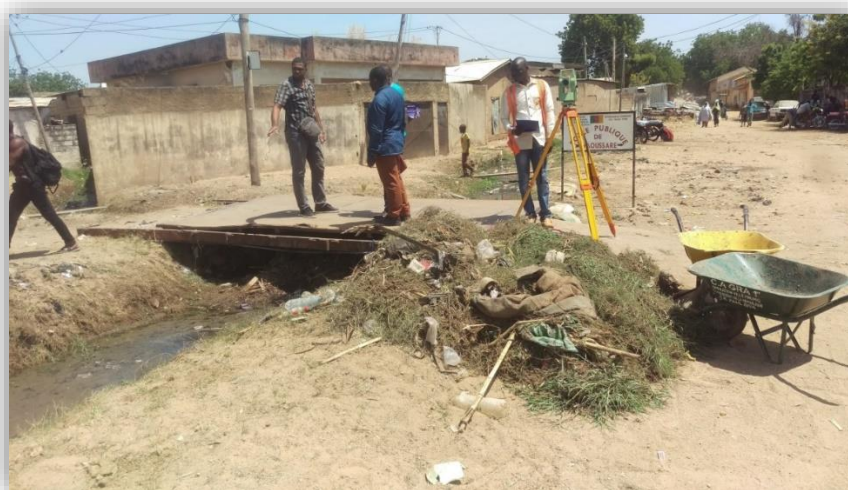
Photo 35: Nettoyage des gouttières bouchées par les feuilles et autres déchets
