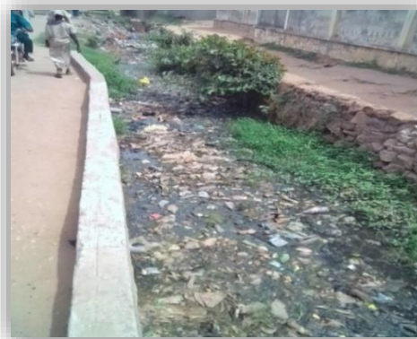
Photo 12: Drainage obstrué par des déchets sur le site du projet
