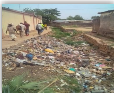
Photo 12: Drainage obstrué par des déchets sur le site du projet
