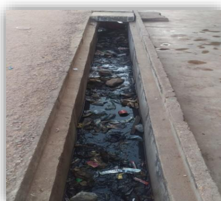
Photo 13: Gouttières routières bouchées par des déchets sur le site du projet
