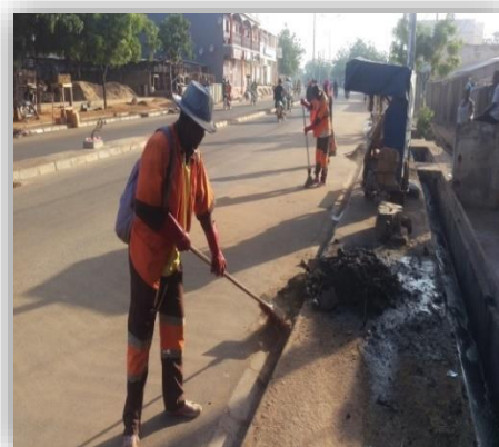
Photo 13: Gouttières routières bouchées par des déchets sur le site du projet
