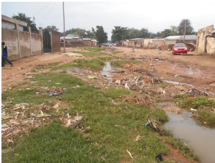
Photo 9 : Voie dégradée au quartier Toupouriré
