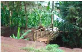
Photo 14: Pont en bois
