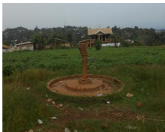
Photo 26: Forage non fonctionnel
