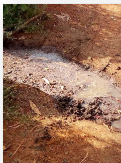
Photo 31: dépôt d'eaux usée ménagère sur une voie
