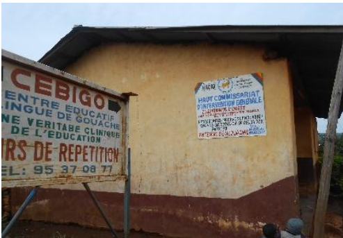
Photo 19: ONG dans la zone
