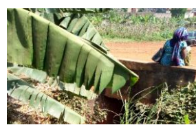
Photo 14: Dalot de traversé
