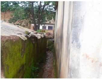
Photo 10: Piste d'accès à une zone
