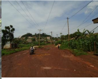
Photo 11: Une voie primaire de la zone
