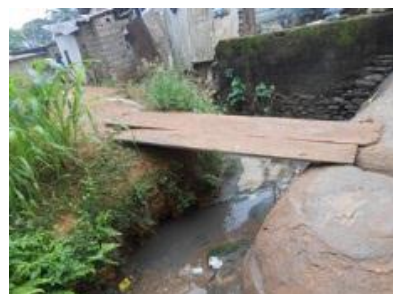
Photo V.10.7 : passerelle en planche posées sur des rochers
