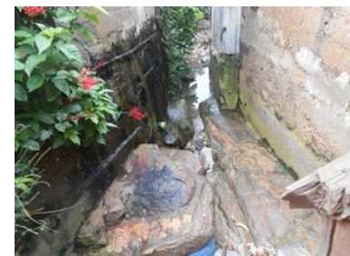
Photo V.10.6 : Emprise du cours d'eau rétrécie par des constructions
