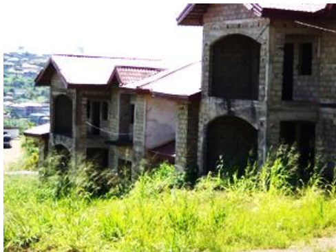
Photo III.3.3 : Partie de la cité en construction
