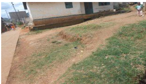
Photo V.9.1 : route piétonne bétonnée non continue servant à la circulation des populations bien qu'elle soit très étroite.
