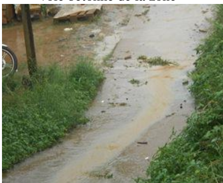
Photo V.10.8 : écoulement des eaux de pluies sur l'unique voie bétonnée de la zone
