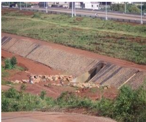
Photo III.3.25 : Recalibrage d'un cours d'eau
