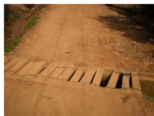
Photo V.8.5 : Ouvrage de franchissement en béton mais recouvert de dalle en planche
