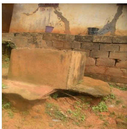
Photo V.7.3 : Puits à ciel ouvert
