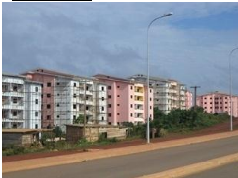
Photo III.3.23 : Partie en construction
