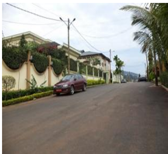
Photo III.3.10 : Allure générale des voies du golf Ntougou
