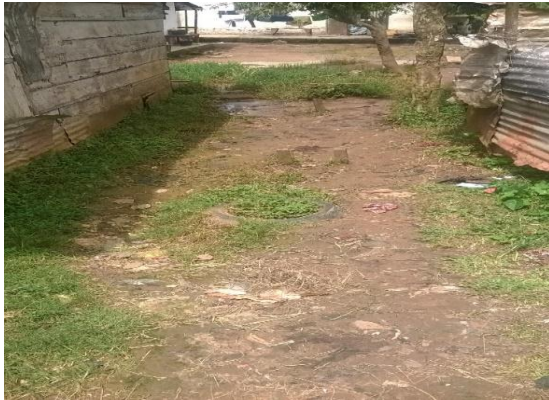
Photo V.3.1 : Voie entre deux bâtiments
