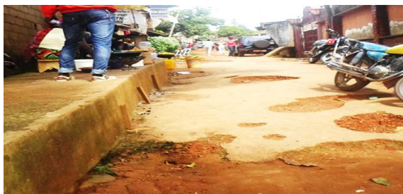
Photo V.6.1 : bitume dégradé
