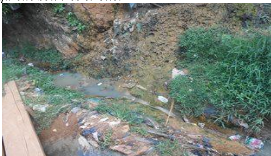
Photo V.9.3 : Rigole à forte pente pouvant atteindre 6%. (face du bâti Z8B4)
