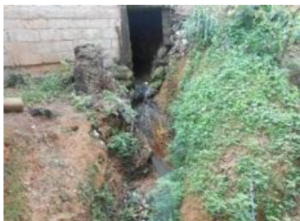
Photo V.10.4 : Drain fait en construction béton, par un riverain.
