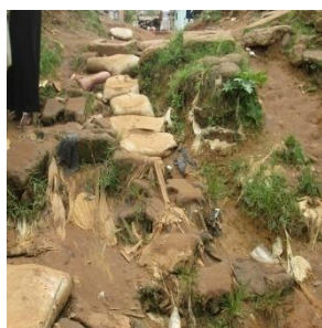
Photo V.5.5 : Présence de sacs remplis de terre végétale servant à boucher les ravines
