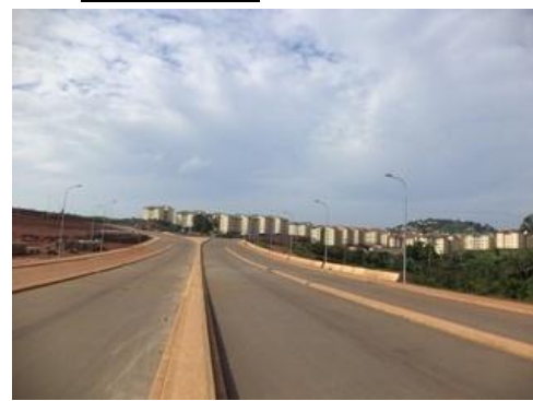
Photo III.3.24 : Allure général du site
