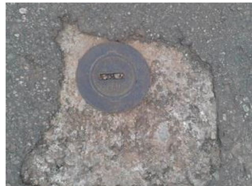
Photo III.3.17 : Réseau d'alimentation en eau potable
