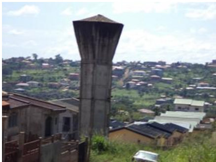
Photo III.3.5 : Château d'eau commun en construction
