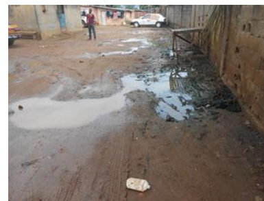
Photo V.10.3 : Stagnation des eaux sur la voie causée par l'absence d'ouvrage d'assainissement.
