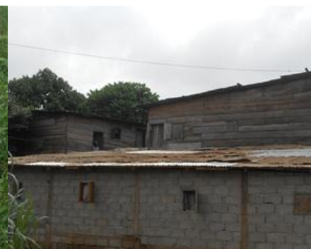
Photo V.10.9 : Type de bâti de la zone : en planche et en parpaing
