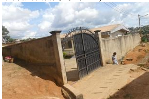
Photo V.9.4 : Bâti Z8B172 situé juste avant le poteau électrique en se dirigeant vers le marécage
