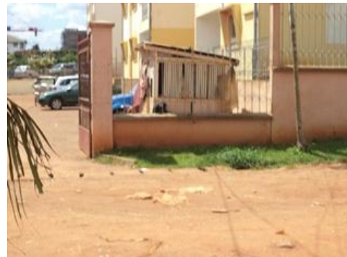
Photo III.3.30 : Box de sécurité à l'entrée
