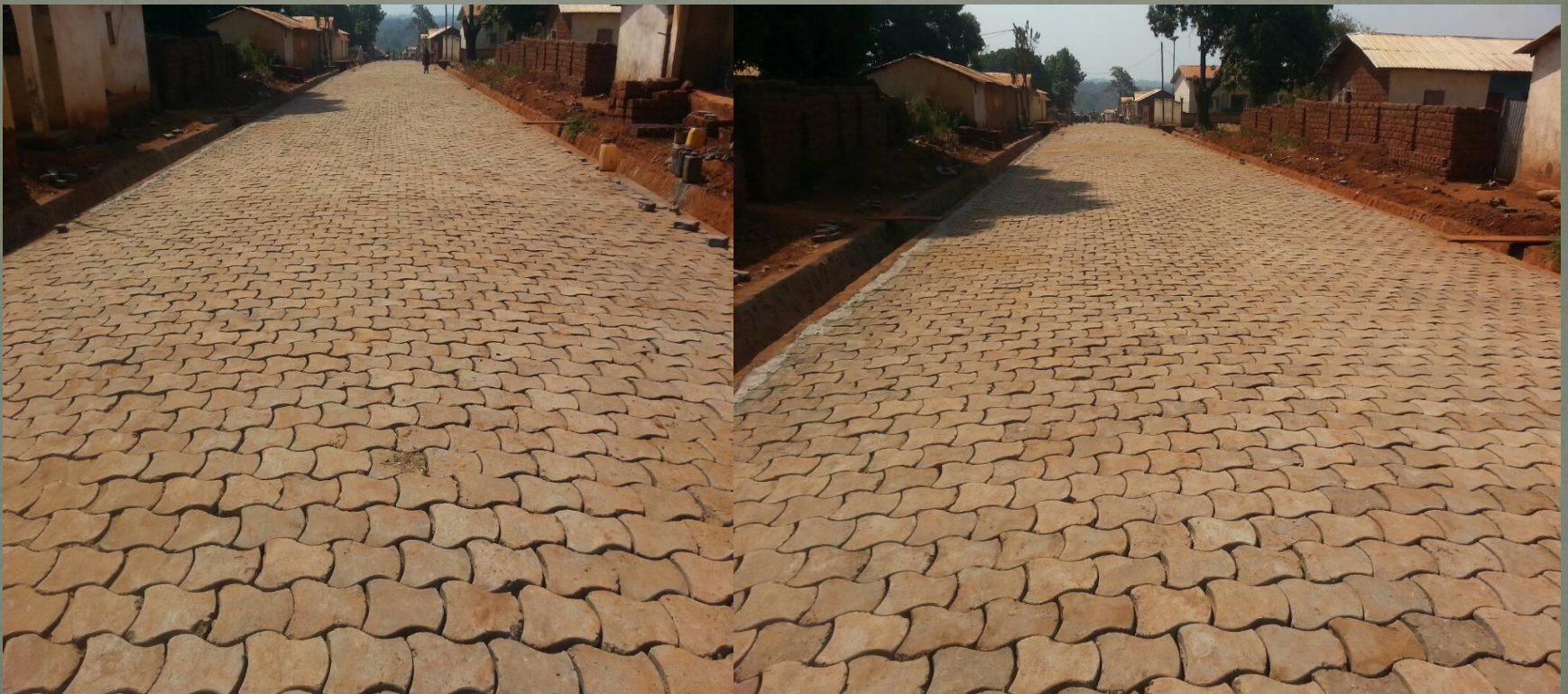
Etat de la route après les travaux de pavage
