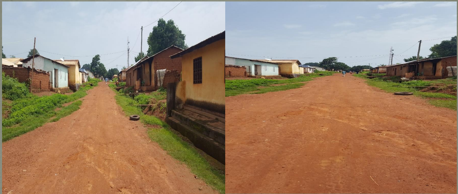
Une vue de la route dans le quartier Djalingo avant le début des travaux
