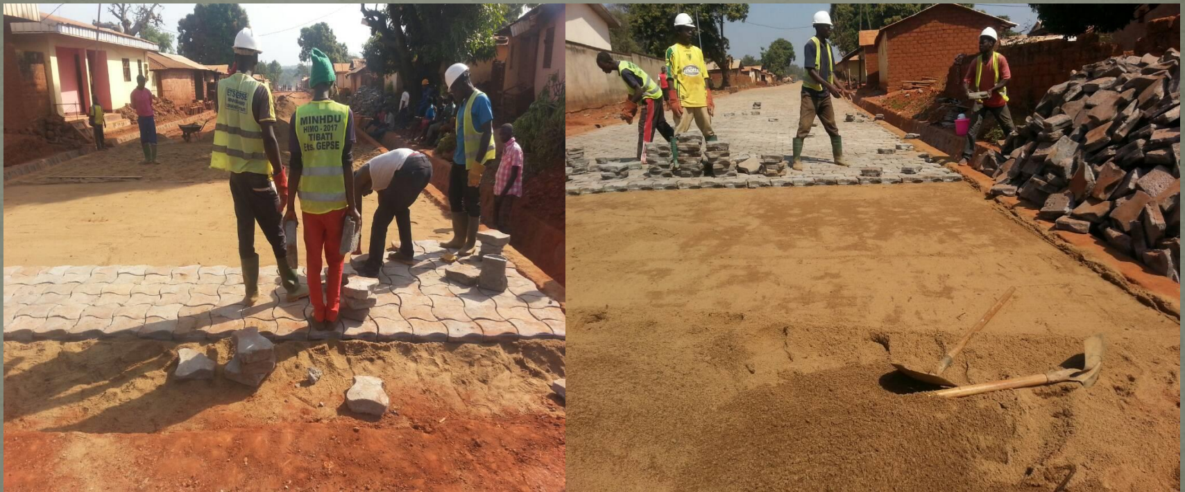
Une vue pendant la pose des pavés
