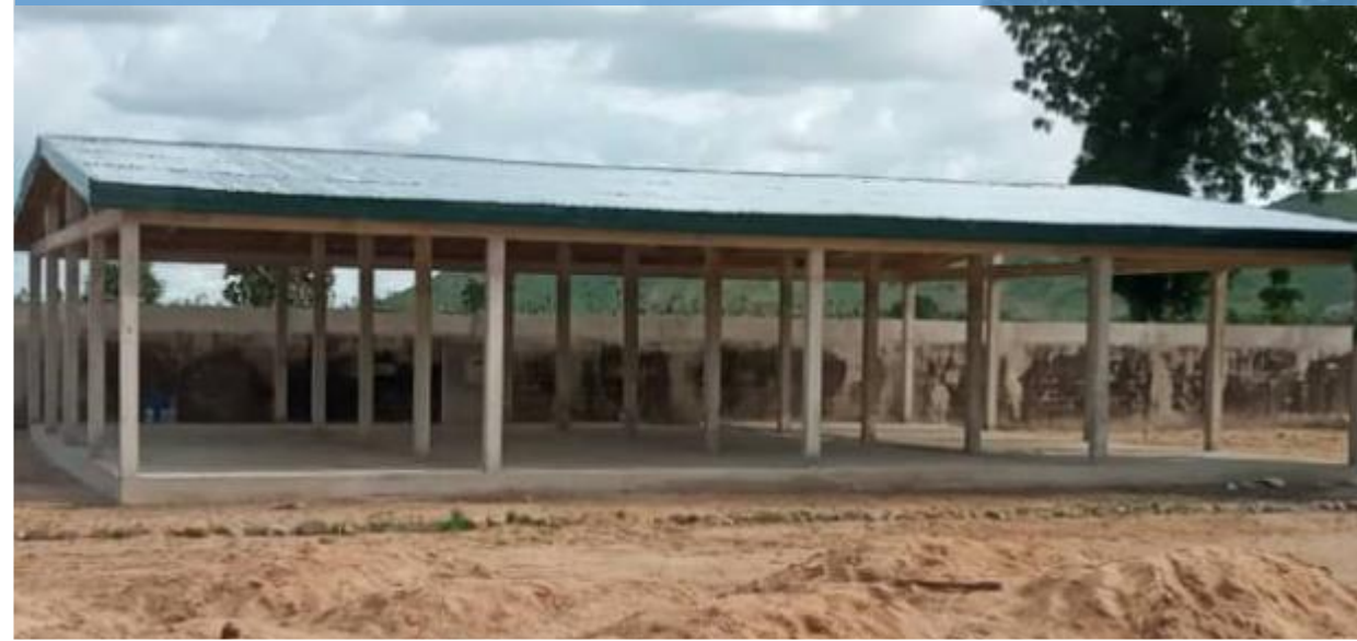
Aménagement du site de fabrication des pavées pour HIMO
