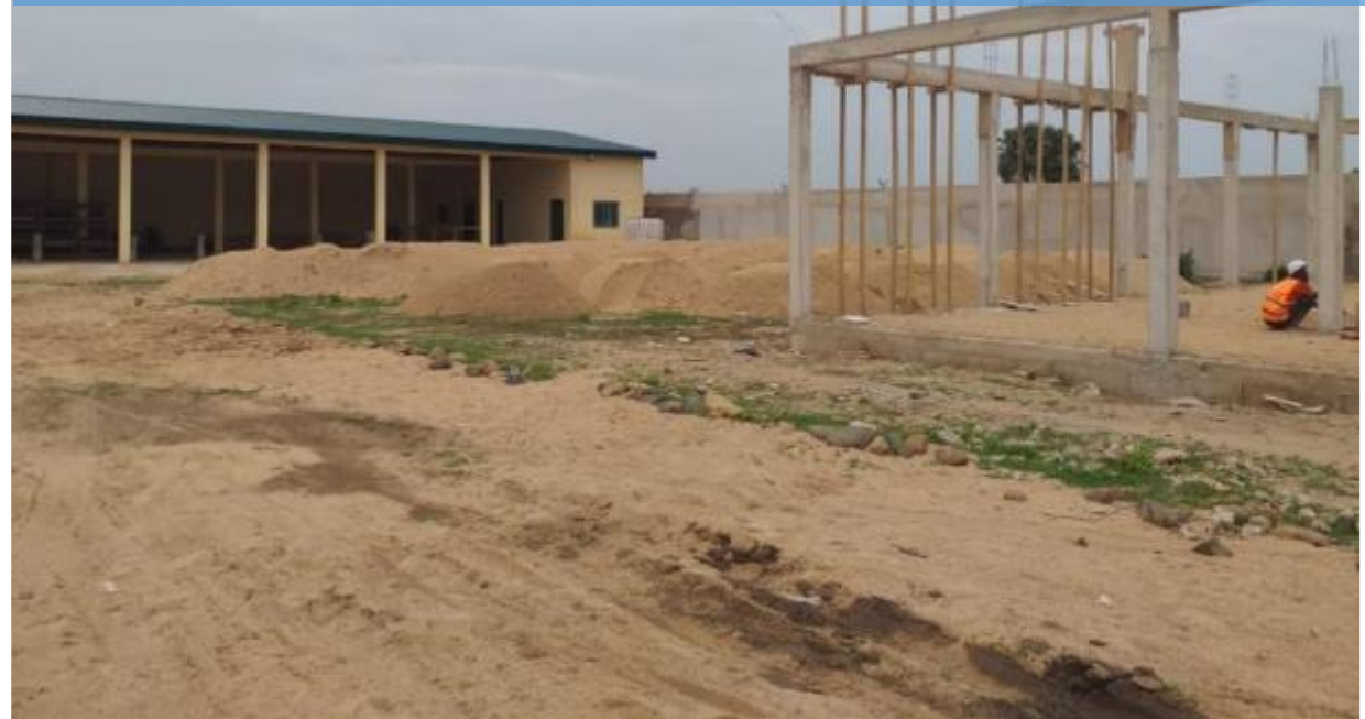
Aménagement du site de fabrication des pavées pour HIMO
