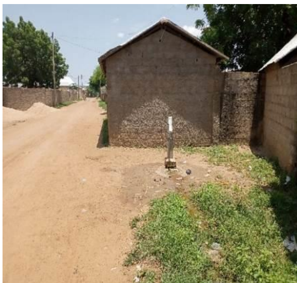
Photo 5: Maison en briques de terre
