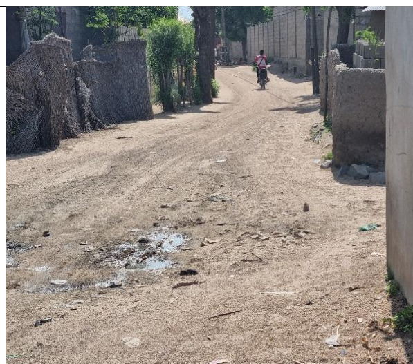
Photo 4: Emprise irrégulière et exigüe
