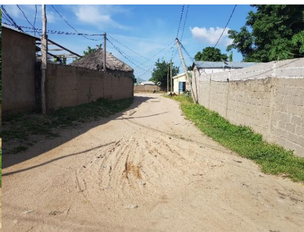
Photo 6 : Étranglement de l'emprise vers la fin de l'axe au niveau du carrefour Mongoroyel
