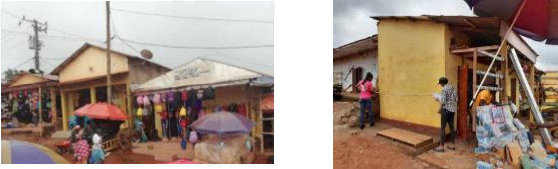
Figure 11: Vue des installations fixes au marché de Mokolo
