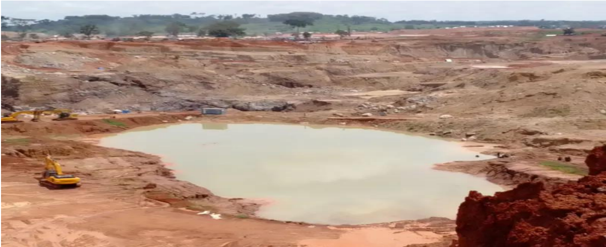
Photo 2 : Exploitation minière semi-mécanisée
